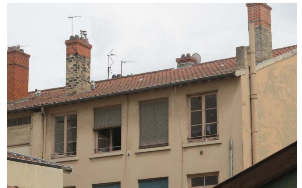
Façade Nord avant travaux
