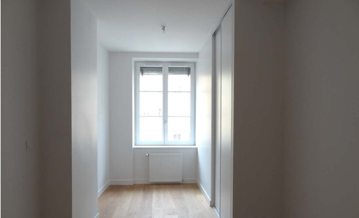
Vue d'une chambre après travaux
