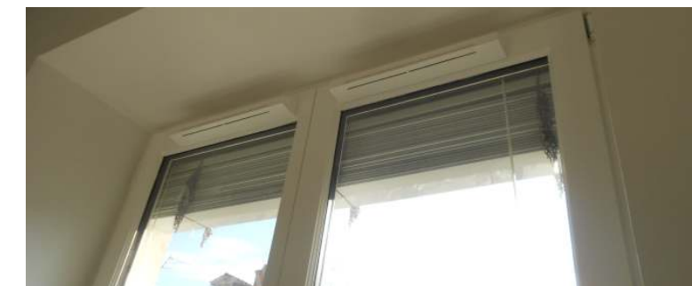
Nouvelles fenêtres double vitrage et BSO
