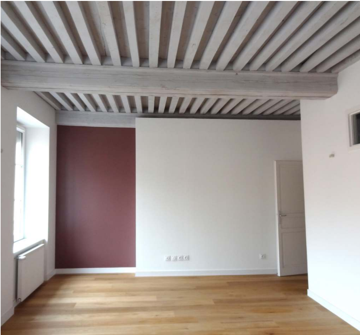
Vue du salon après travaux
