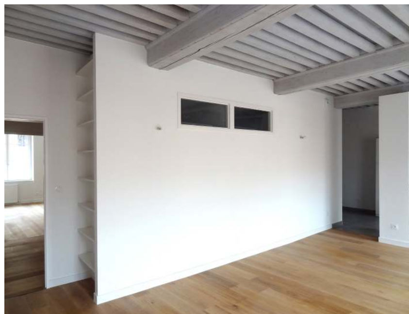
Création d'imposte pour amener la lumière naturelle dans les salles de bains
