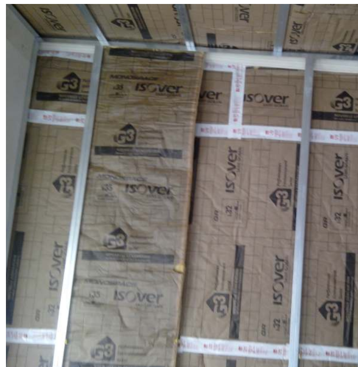
Isolation des murs avec de la laine minérale
