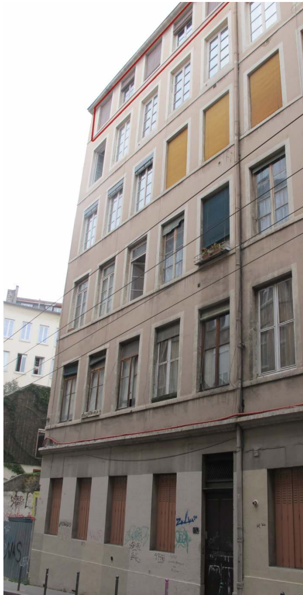
Vue extérieure avant travaux
