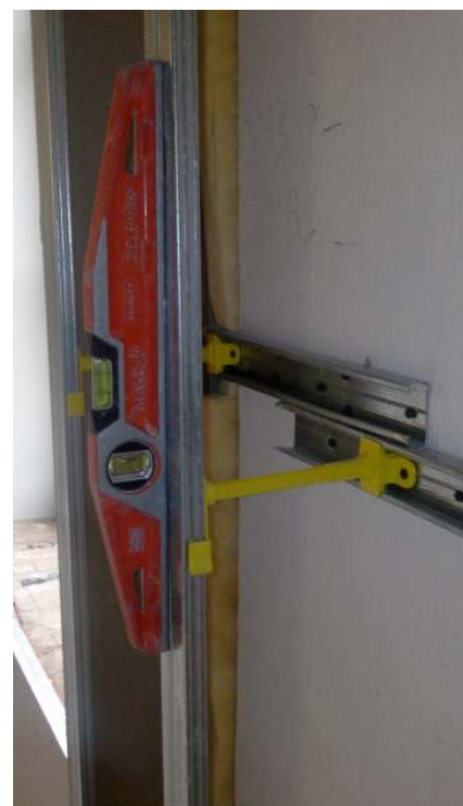
Système de fixation pour doublage acoustique
